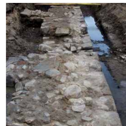
Kurtinmuren förband bastioner med varandra och var en del av försvaret i fästningen
