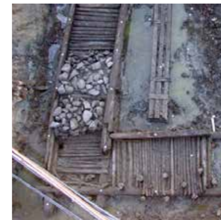
Sänkverket låg utmed älvstranden och bestod av träkistor på älvens botten fyllda av sten och jord som hindrade fartyg att nå staden
