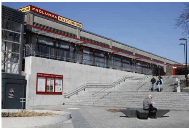
Kulturhusets entrétrappa, ombyggd i början av 2000-talet.
