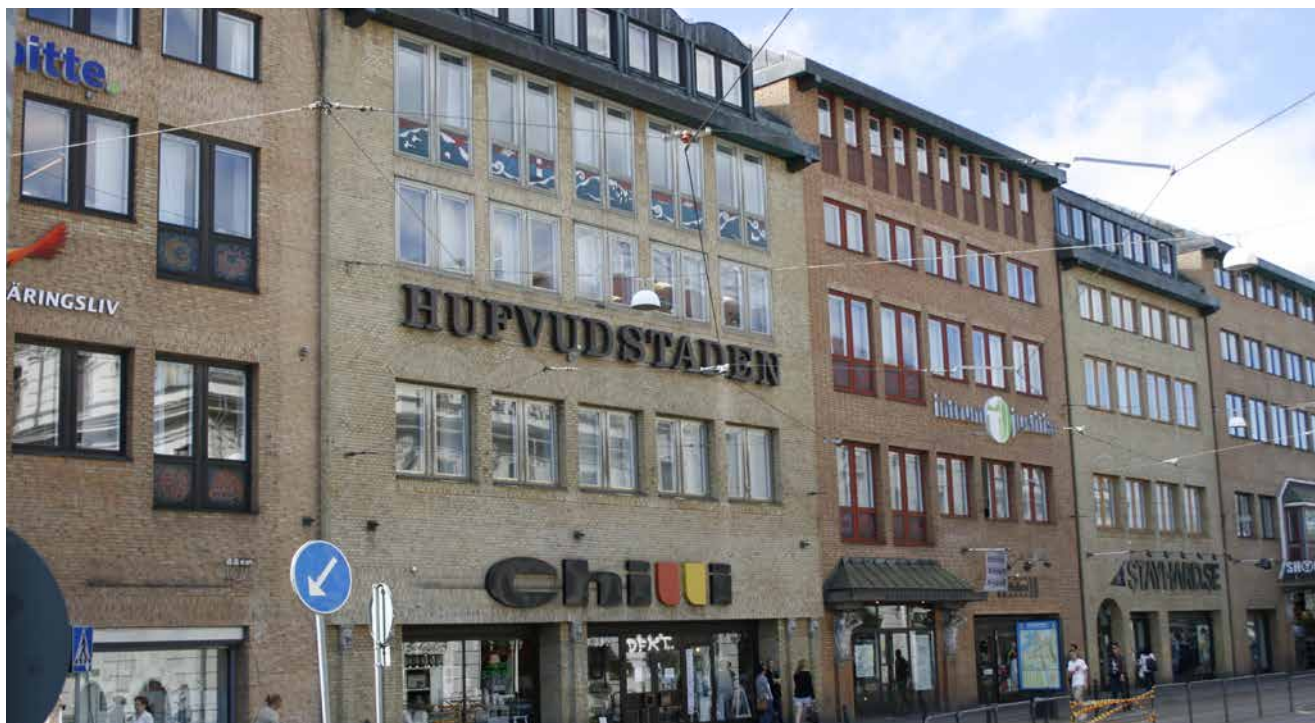
Kvarteret Härbärgat ger uttryck av att vara flera olika fastigheter genom sin fasadindelning. Foto: Anna Reuter Metelius
