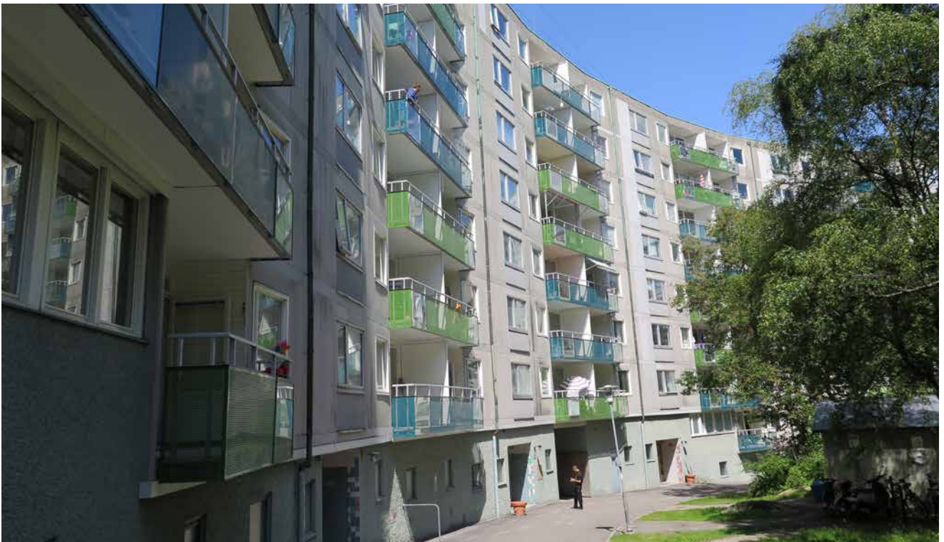
Husen har tilläggsisolerats och fått nya balkongfronter i blått och grönt. Foto: Sanja Peter
