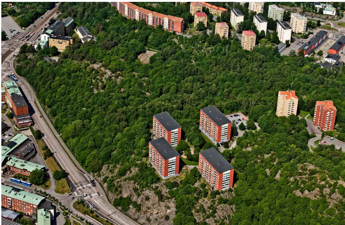
Byggnaderna har karaktäristiska fasader i brännlackerad röd eternit och med balkonger i rå betong. Foto: Göteborgs Stad
