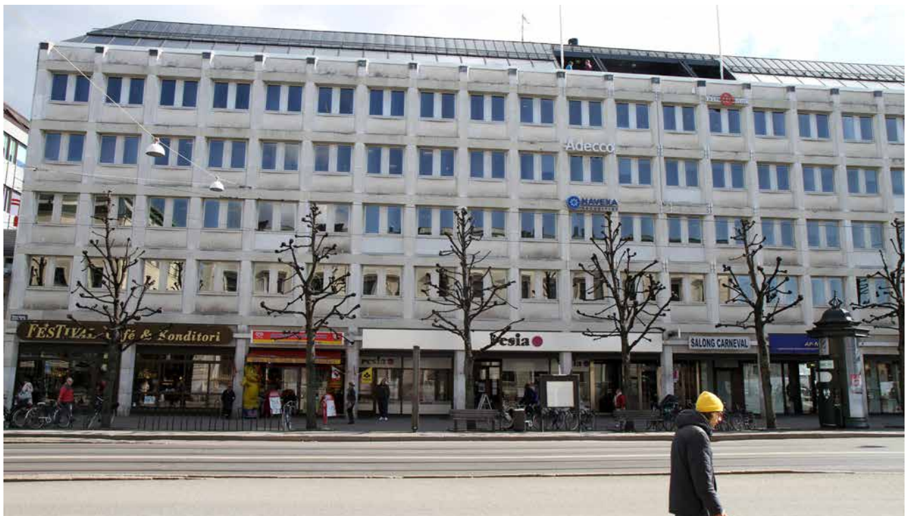
Del av kontorsbyggnaden sedd från Östra Hamngatan. Foto: Anna Reuter Metelius
