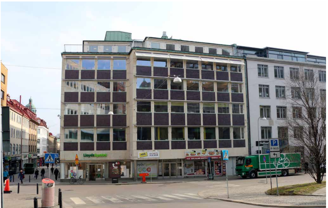
Före detta Malmströms herrekipering utgör med sin violetta mosaikfasad en viktig del i stadsbilden längs Kungsgatan.
