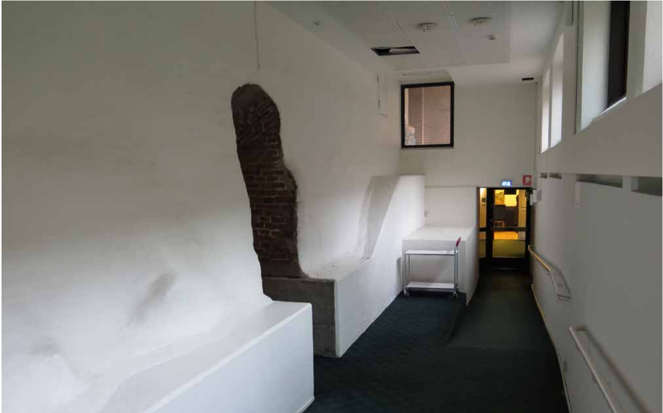
Öppning från modern korridor till de bevarade 1700-talsvalven.
