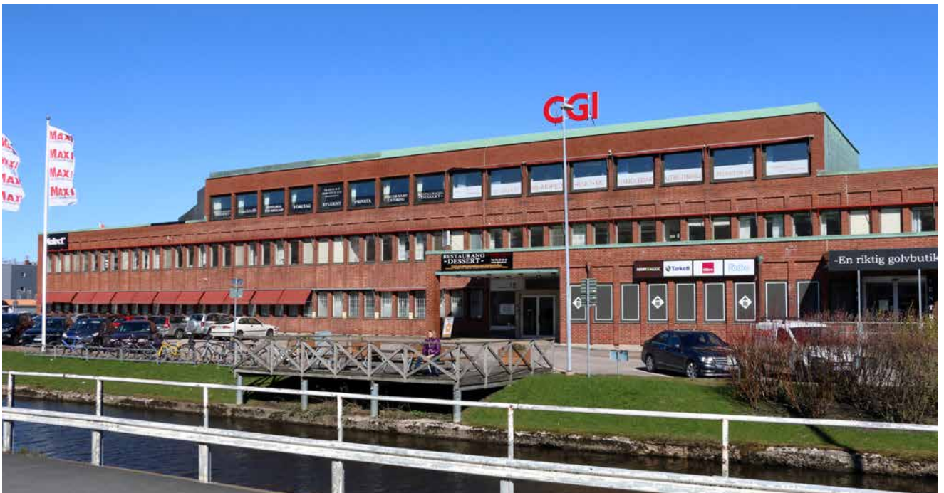
Wezäta Melins tryckeribyggnad vid Mölndalsån. Foto: Rickard Ribbås
