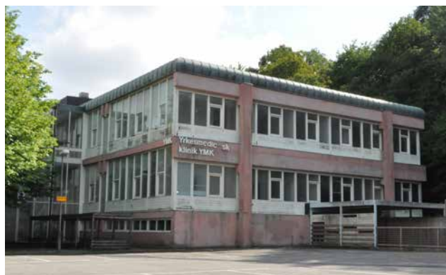
GAKO-huset innan rivning på 2010-talet.
