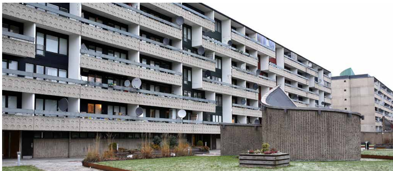
Fasad mot gården. Balkongfronterna är dekorerade med cirkelformer formgjutna i betongen. Foto: Anna Reuter Metelius
