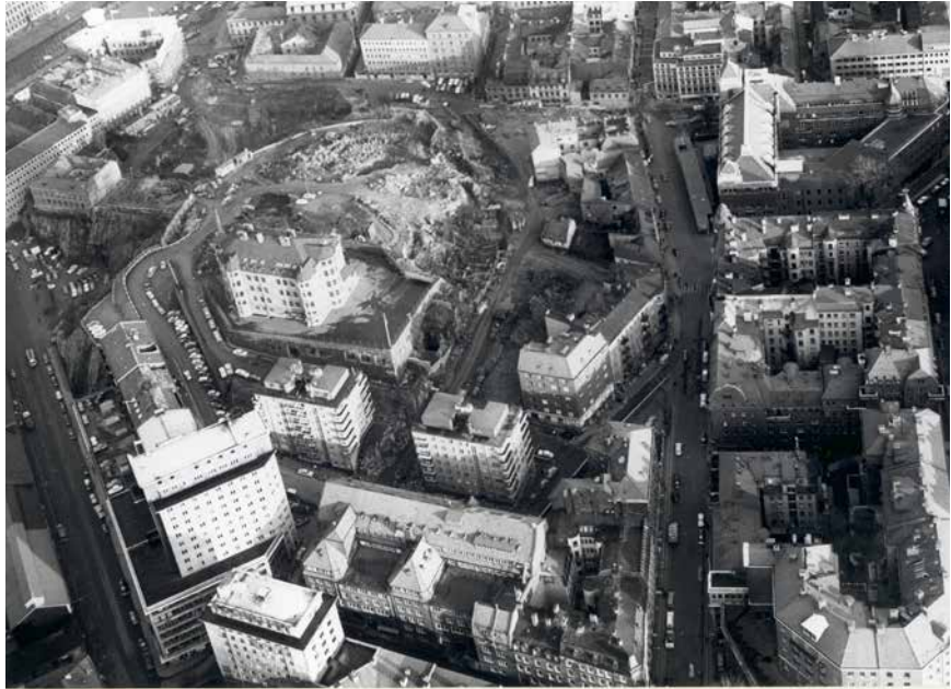
Punktsanering på Stora Otterhällan. I bildens centrala parti rivningsområdet där Södra Liden m.fl. gator legat. Foto från 1962, fotograf okänd
